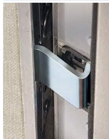
Particolare della versione HH, cerniera a scomparsa.
